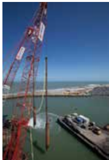
Terminal méthanier de Dunkerque - FRANCE
